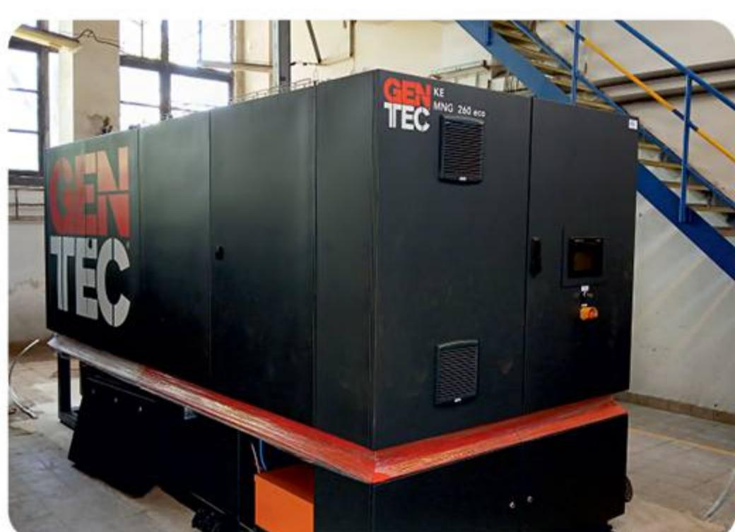
zprovoznili moderní kogenerační jednotku. Tzv. kogenerace, která umožňuje kombinovanou výrobu elektřiny a tepla, je jedním z nejefektivnějších způsobů využívání energie. Na rozdíl od tradičních elektráren, které umožňují vzniku tepla uniknout do atmosfé
